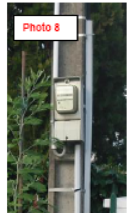
Compteur extérieur apparent
